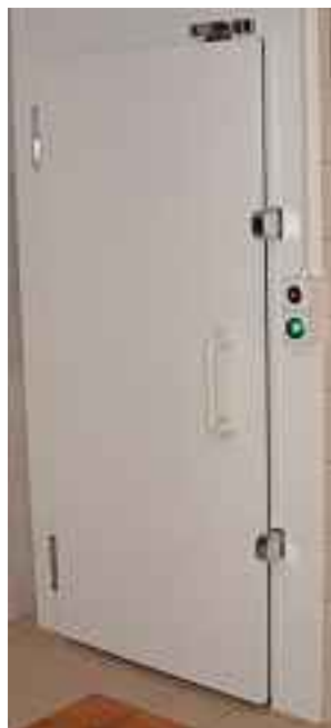
Selbstschliessende Tür mit Badewannengriff für Kühl- und Tiefkühlräume
